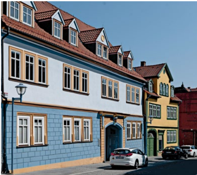
Für die Sanierung der Vorderseite des Hauses Nummer 9 in der Lucas-Cranach-Straße erhielten die Besitzer 2023 den Fassadenpreis der Stadt Gotha.
